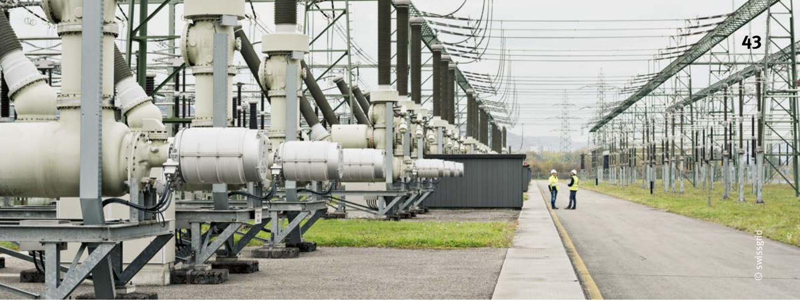
Modules PASS (plug and switch system) du poste de couplage aérien 380 kV à Laufenburg
