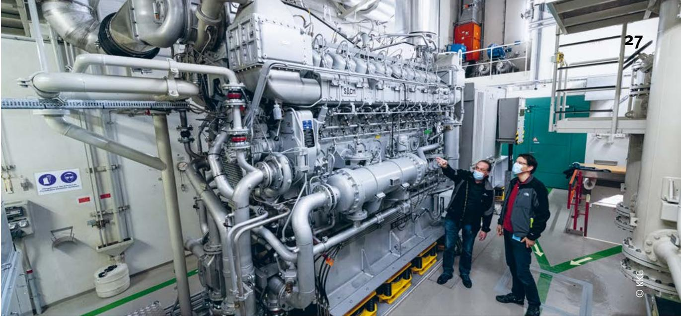
André Egger, chef des systèmes traditionnels (à gauche), et Max Brugger, chef de l'information de Kernkraftwerk Gösgen-Däniken AG, devant l'un des quatre moteurs diesel de secours SACM de 2,9 mégawatts.
